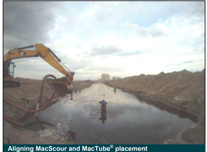
Aligning MacScour and MacTube® placement
