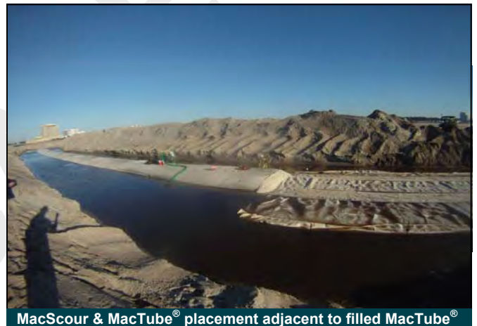
MacScour & MacTube® placement adjacent to filled MacTube®
